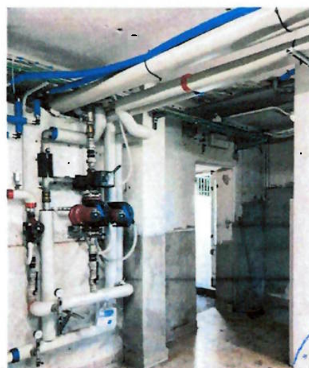
Seminterrato — locale tecnico
