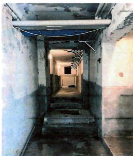
Seminterrato — corridoio di ingresso
