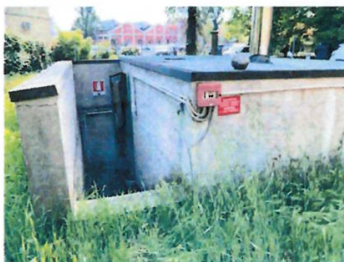
Accesso centrale termica
