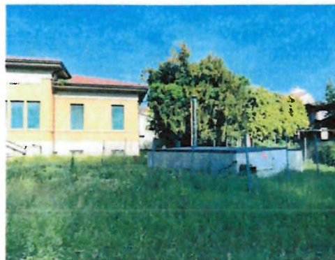
Prospetto est — centrale termica
